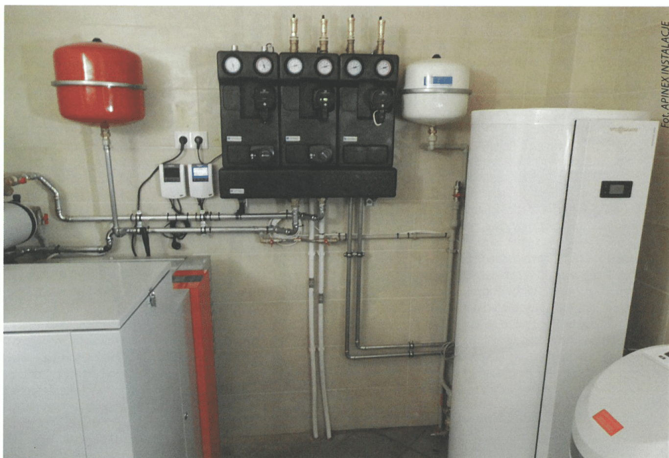
Fot. 1. Montując grupę pompową zyskuje się fabryczny, gotowy, a zarazem szczelny zespół pozwalający na połączenie kotła z instalacją c.o.
