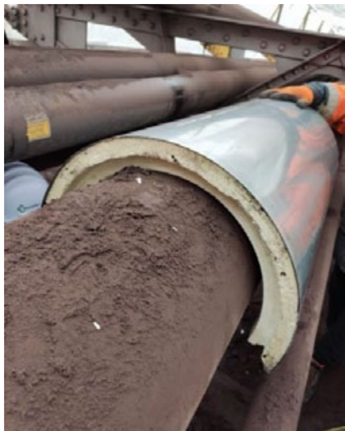
Sprawdzanie wymiarów izolacji
