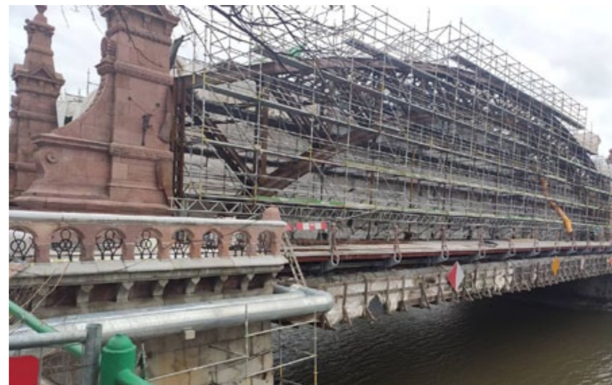
Remont wrocławskiego Mostu Zwierzynieckiego
