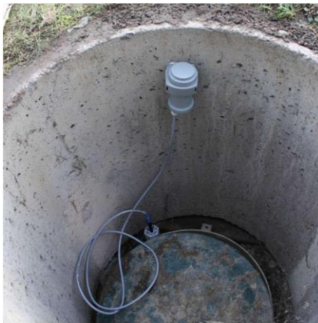
Rys. 6 Montaż sondy w zbiorniku
