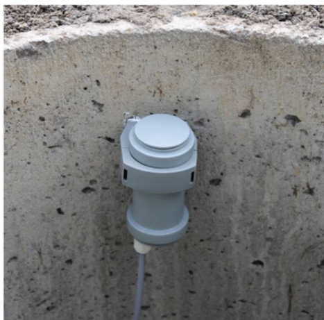
Rys. 5 Nadajnik zamontowany w uchwycie
