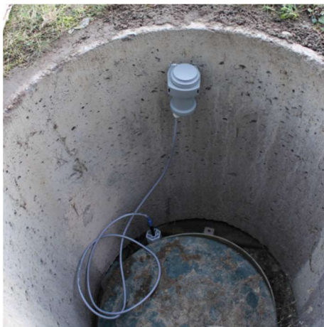
Rys. 6 Montaż sondy w zbiorniku
